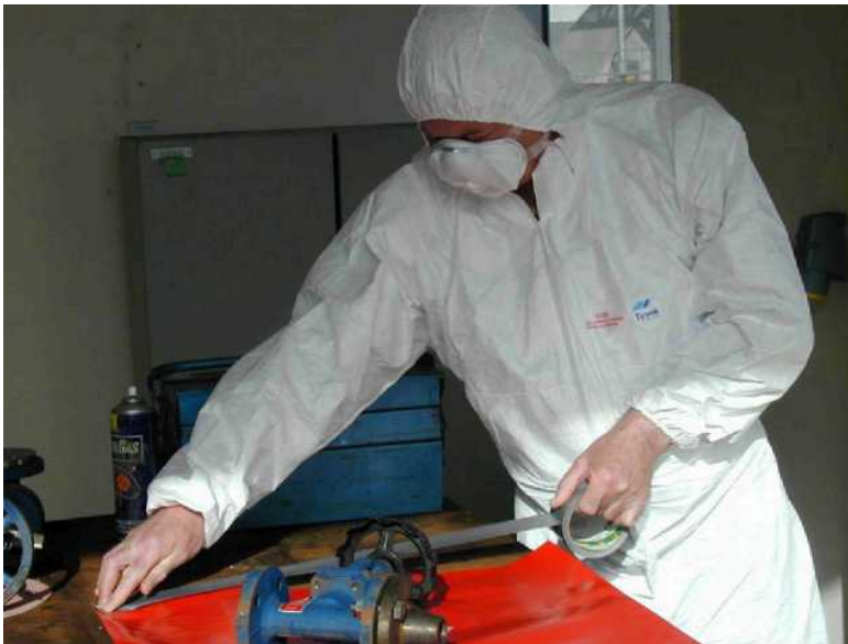
Rysunek 11.3 Wykorzystanie taśmy i arkusza polietylenowego do ochrony miejsca pracy przez oczyszczeniem zaworu z uszczelek azbestowych
