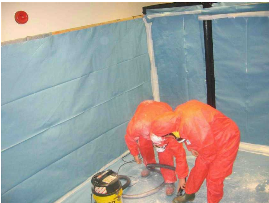
Rysunek 7.1 Szkolenie praktyczne w korzystaniu z odkurzaczy typu H przy usuwaniu symulowanego zanieczyszczenia (talk). Rysunek dostarczony przez UK HSE
