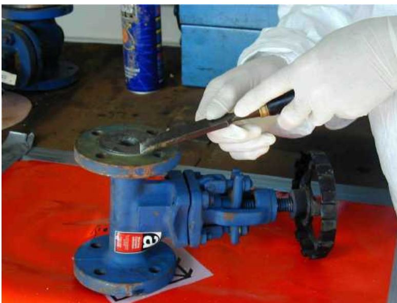
Rysunek 11.5 Wykorzystanie wyłącznie narzędzi ręcznych do usunięcia z zaworu uszczelki i pozostałości azbestowych
