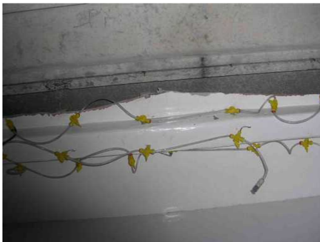
Rysunek 12.10 Przykład wtrysku o wielu końcówkach, stosowanego do zwilżania metodą natryskową izolacji azbestowej
