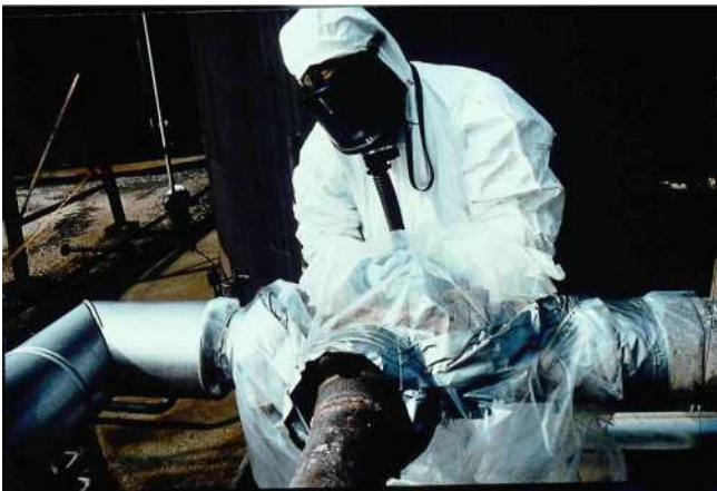
Rysunek 12.12 Worki rękawicowe stosowane w kontrolowanym usuwaniu otuliny azbestowej (zdjęcia zostały dostarczone przez INRS; prawa autorskie INRS)
