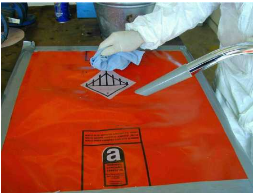
Rysunek 11.7 Dokładne oczyszczanie terenu pracy, przy wykorzystaniu odkurzacza typu H i mokrych szmatek
