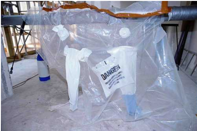
Rysunek 12.12 Worki rękawicowe stosowane w kontrolowanym usuwaniu otuliny azbestowej (zdjęcia zostały dostarczone przez INRS; prawa autorskie INRS)
