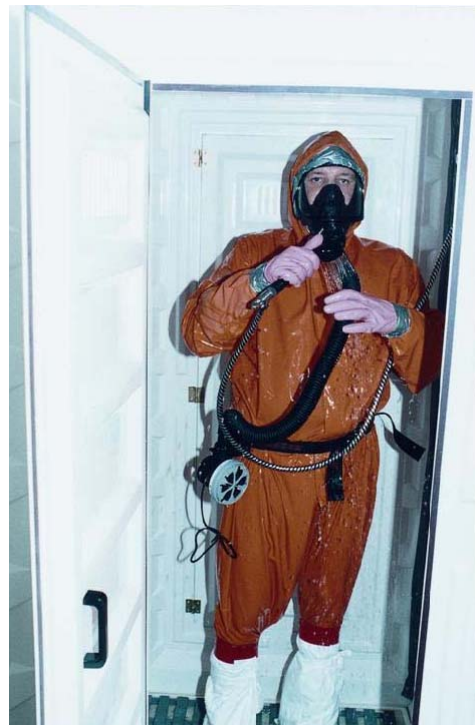
Rysunek 12.5 Oczyszczanie odkurzaczem typu H, w prysznicu w kombinezonie wodoodpornym, następnie kąpiel pod prysznicem przed zdjęciem sprzętu ochrony dróg oddechowych (zdjęcia dostarczone przez INRS; prawa autorskie INRS zastrzeżone)
