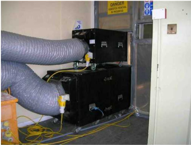
Rysunek 12.2 Generatory podciśnienia i kanały odpływu powietrza, wizjery i znaki ostrzegawcze
