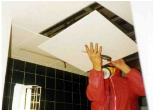
Rysunek 12.13 Ostrożne usuwanie płyty azbestowej
