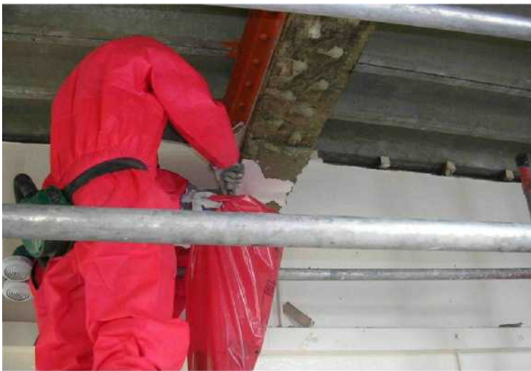
Rysunek 12.11 Opakowywanie w worki odpadów w pobliżu punktu usuwania w celu zapobieżenia ich rozprzestrzenianiu się i zminimalizowania narażenia na ich działanie
