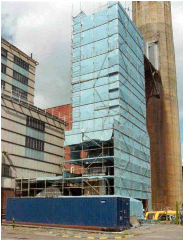
Rysunek 12.3 Osłona do usuwania otuliny z przewodu kanału gazowego
